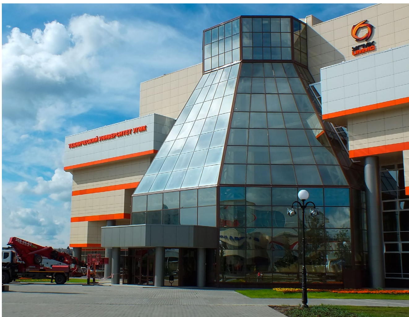
Объект: г. Верхняя Пышма. Технологический Университет Изготовитель конструкции: ООО ОАЗИС Система: F50
