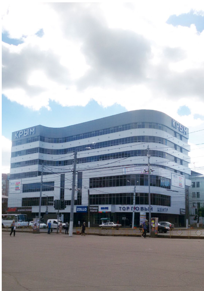
Объект: г. Киров. Торговый Центр КРЫМ Изготовитель конструкции: ООО Орион-М Система: F50, S70
