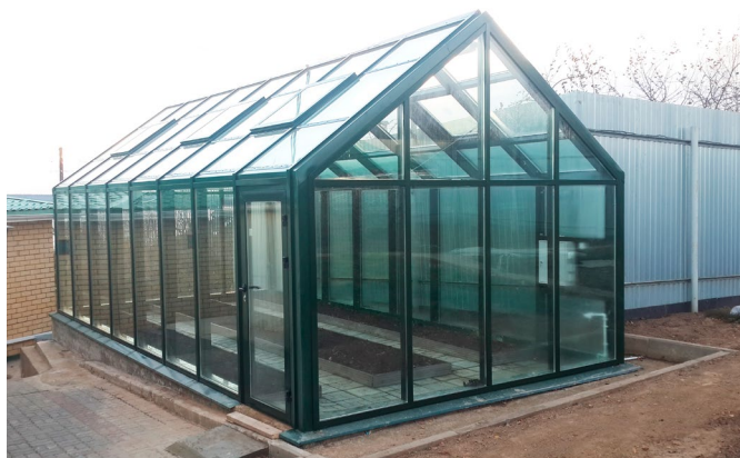
Объект: г. Ярославль. Теплица. Изготовитель конструкции: ООО Арт Профиль Система: F50, S70
