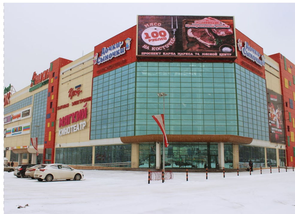
Объект | ТРК «Семейный парк», г. Магнитогорск Изготовитель конструкций | ООО «Окна Люкс» Система | ALUMARK F50, S70, S50
