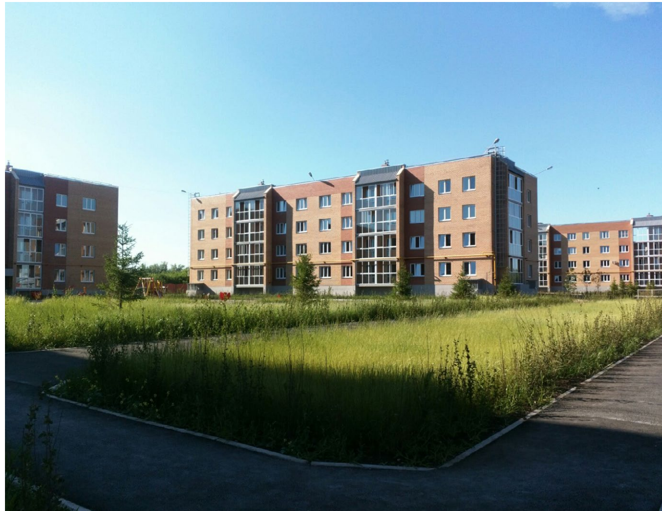
Объект Жилой район малоэтажного строительства, г. Магнитогорск Изготовитель конструкций ООО «Промвысота» Система ALUMARK S44
