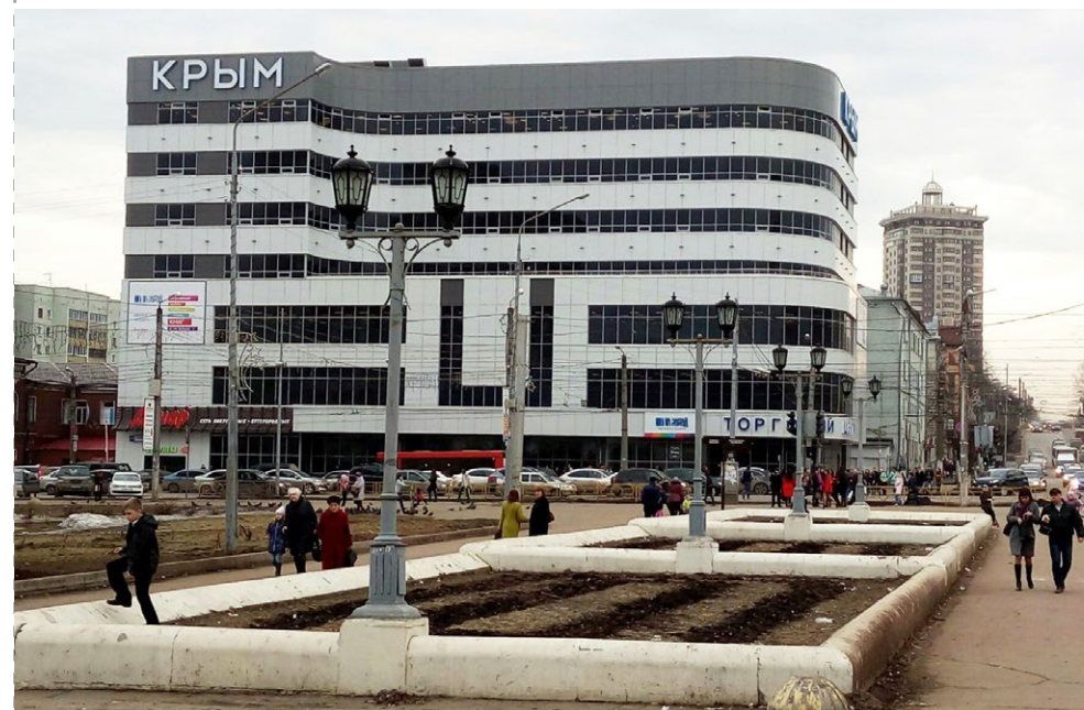
Объект | ТЦ «Крым», г. Киров Изготовитель конструкций | ООО «Орион – М» Система | ALUMARK F50
