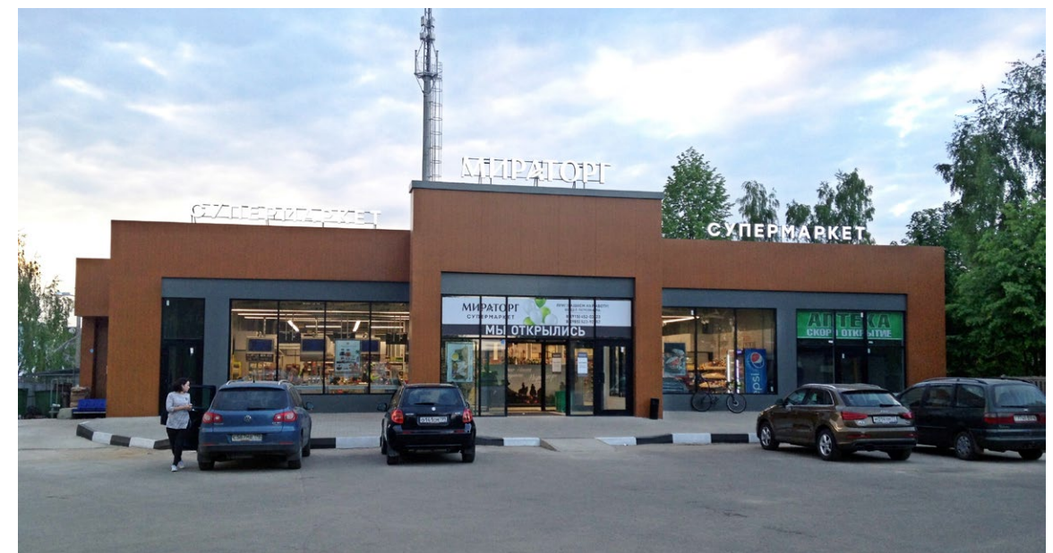
Объект | Супермаркет Мираторг, МО, Петрово Дальнее Изготовитель конструкций | ООО Про Павильон Система | ALUMARK F50, S70
