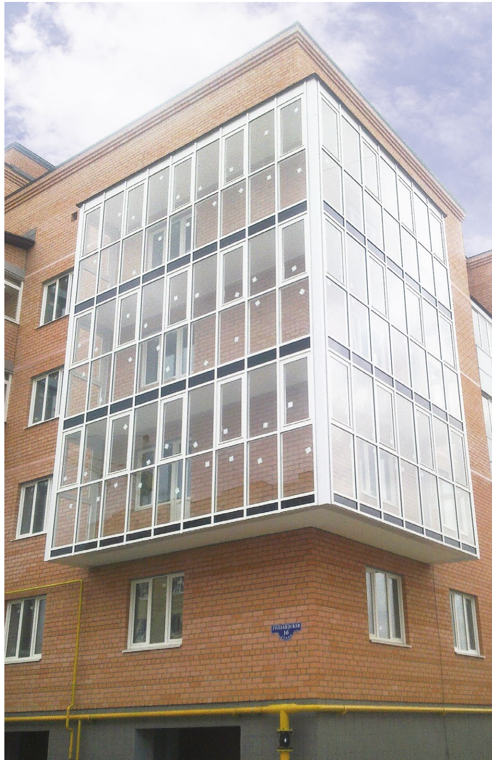
Объект Жилой комплекс, г. Тверь Изготовитель конструкций ООО Лидер Система ALUMARK F50 S50
