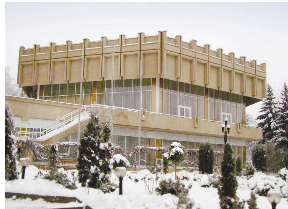
Объект Санаторий «ДОН», г. Пятигорск Изготовитель конструкций ООО «ПАРИТЕТ» Система ALUMARK F50
