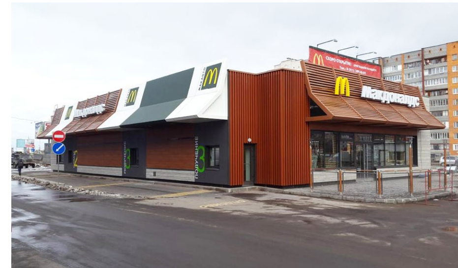
Объект Ресторан, г. Вологда Изготовитель конструкций ООО «Цитиус» Система ALUMARK F50 S70
