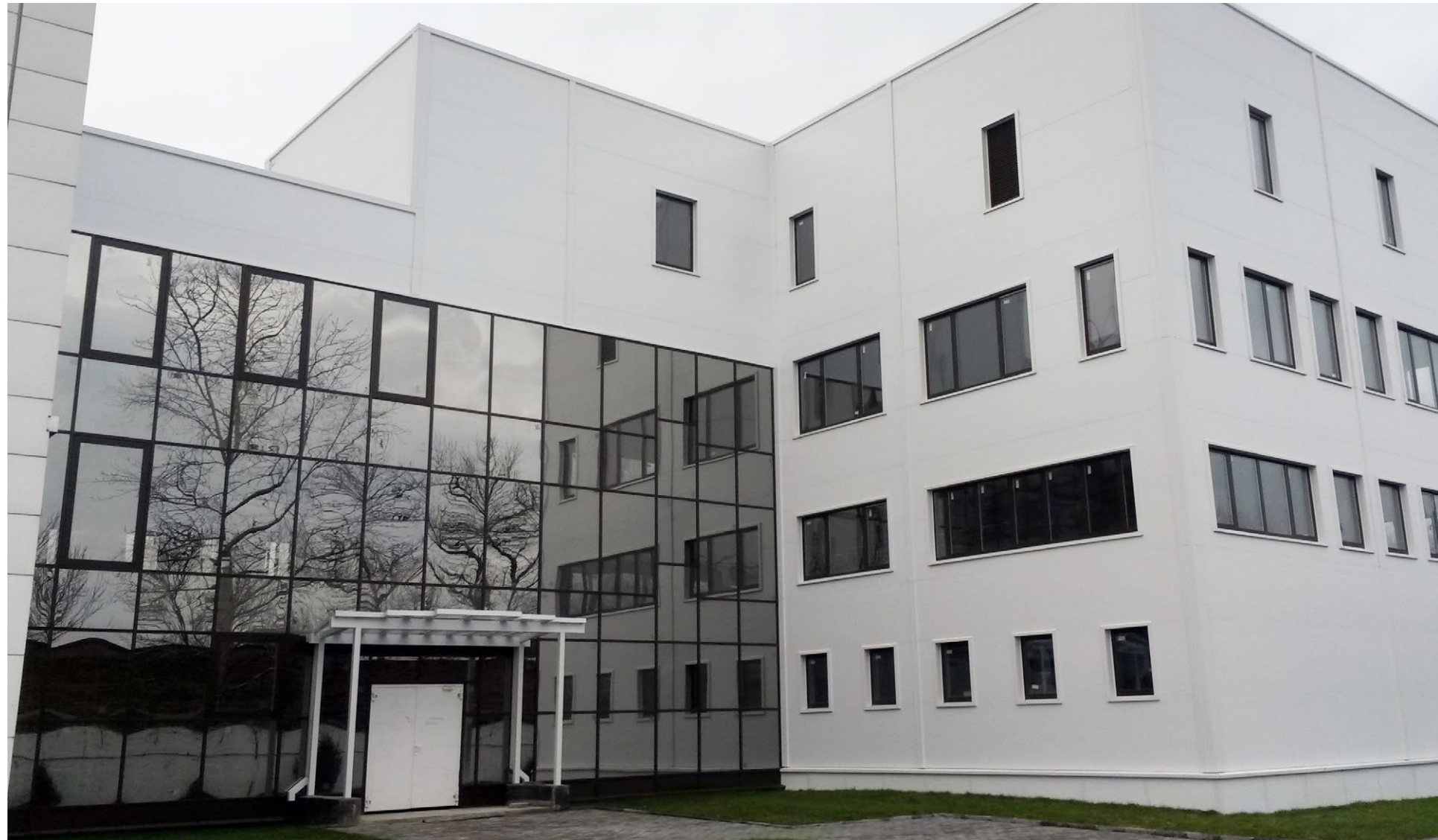
Объект Технопарк, Москва Изготовитель конструкций ООО Дигит Система ALUMARK F50 S70
